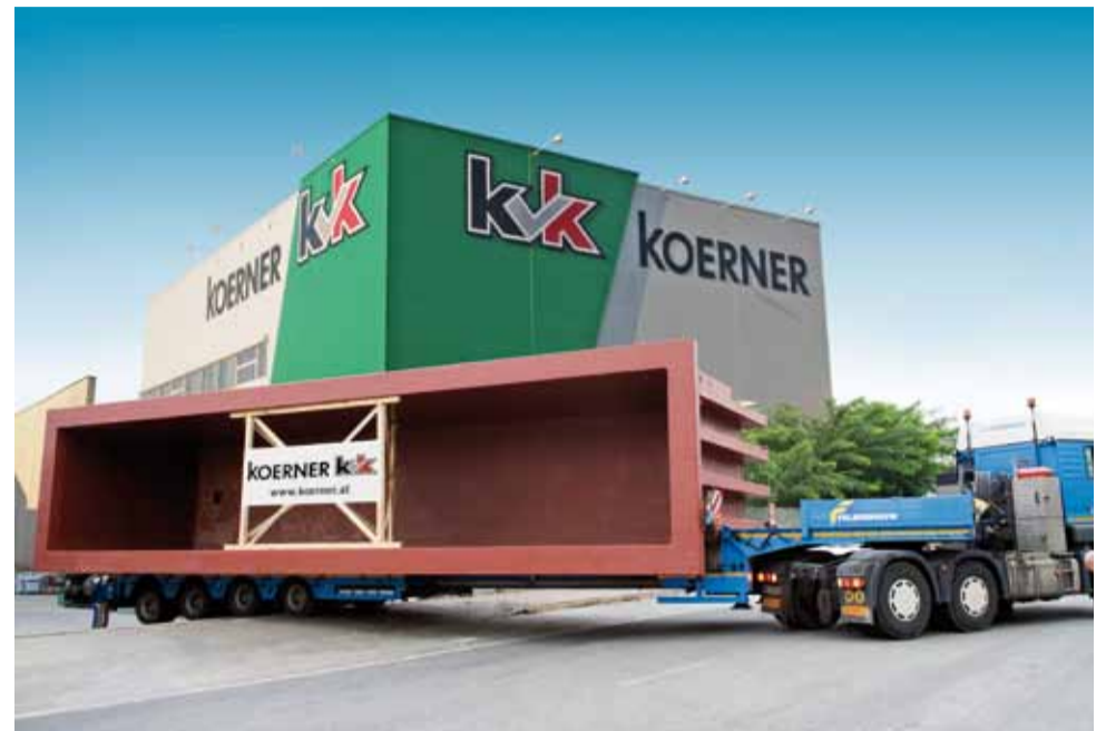
Die neue Produktionshalle der Firma KOERNER, die im vorigen Jahr in Betrieb genommen wurde. Mit der bestehenden Produktionsfläche war man an die Kapazitätsgrenzen gestoßen.
